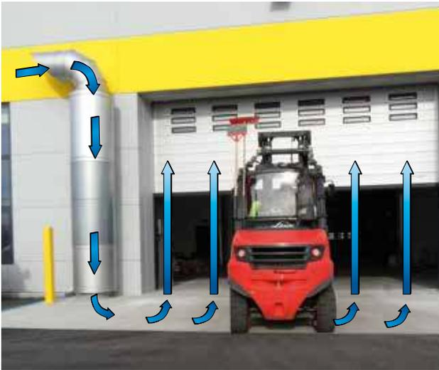
Durch eine spezielle Düsenkonstruktion entsteht eine gleichmäßige, über die gesamte Türbreite reichende, Luftströmung mit Geschwindigkeiten (je nach Torhöhe) bis zu 40 m/sec. Diese bildet eine hocheffektive Schutzbarriere gegen eintretende Kaltluft und sorgt für optimale Umgebungsbedingungen für Personen auch direkt hinter dem geöffneten Tor. Die Anlage kann im Rauminnen auf Wunsch mit Heizregister hinter dem Tor, als auch im Außenbereich vor dem Tor (Umluftanlage), installiert werden.
